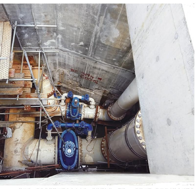
首要的工程是將橫跨河道大大小小的公共管道設施一併整理及移離河道,期間須建造大型豎井於河底進行隧道工程。
