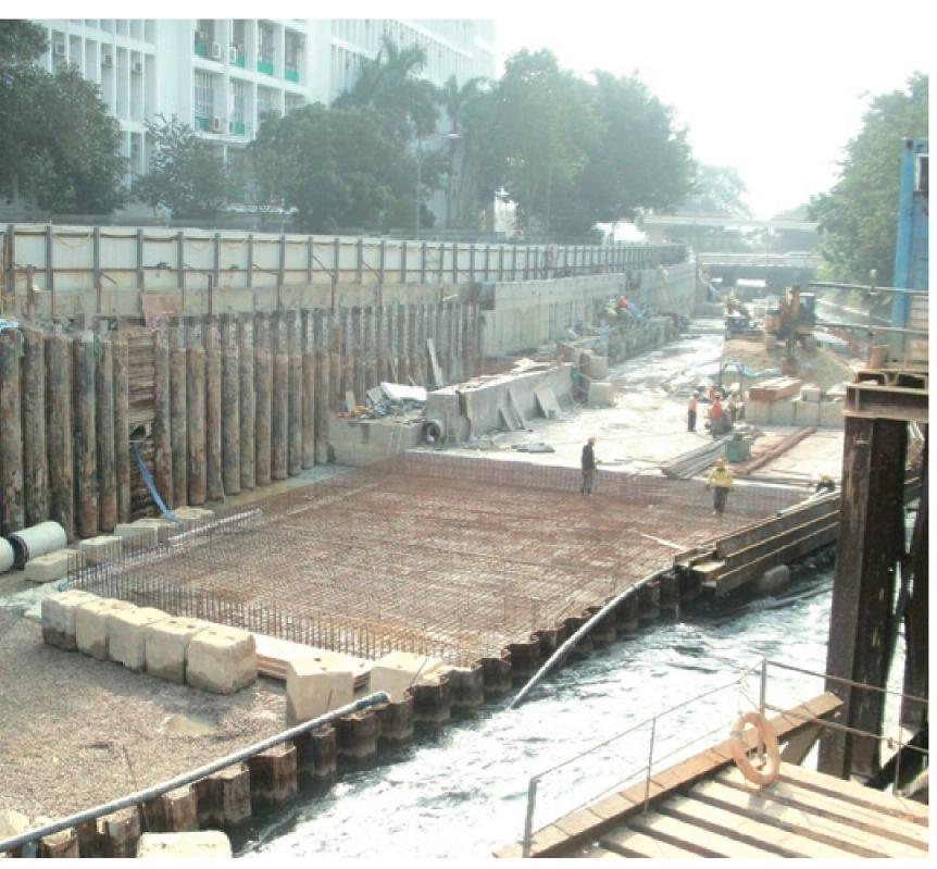
另一改善排洪策略是挖深河床:先鞏固河堤,再挖深河道及重建河床。
