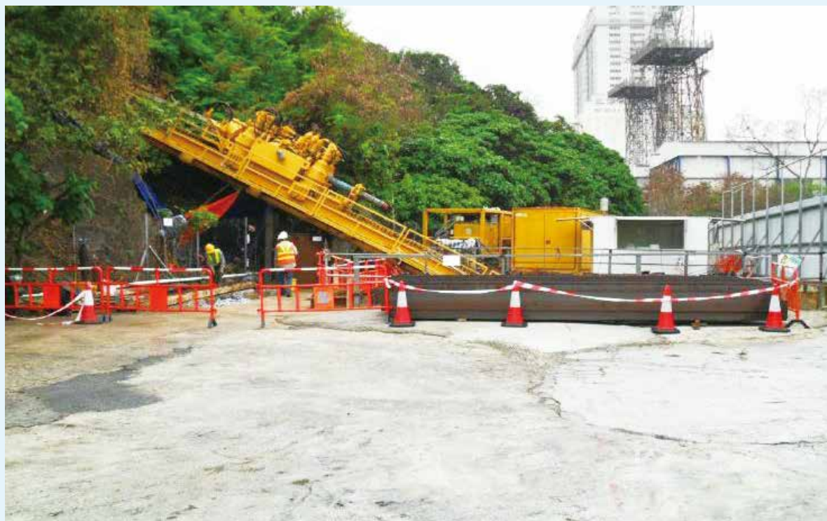
Setup of horizontal directional drilling 水平定向鑽挖設置
