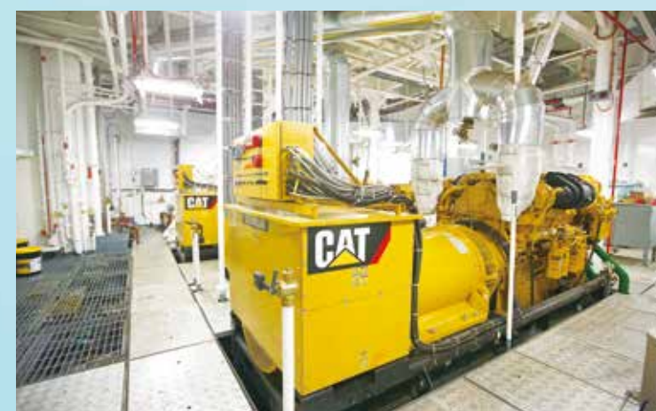
Biodiesel power generator 生物柴油發電機
