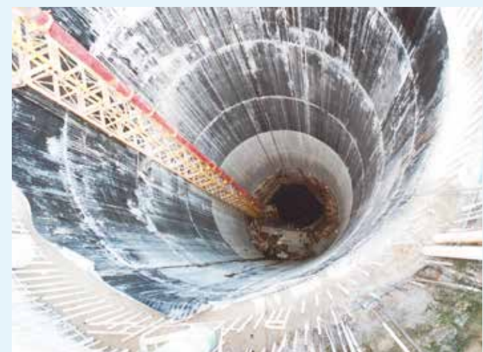
Chai Wan drop shaft under construction 興建中的柴灣豎井
