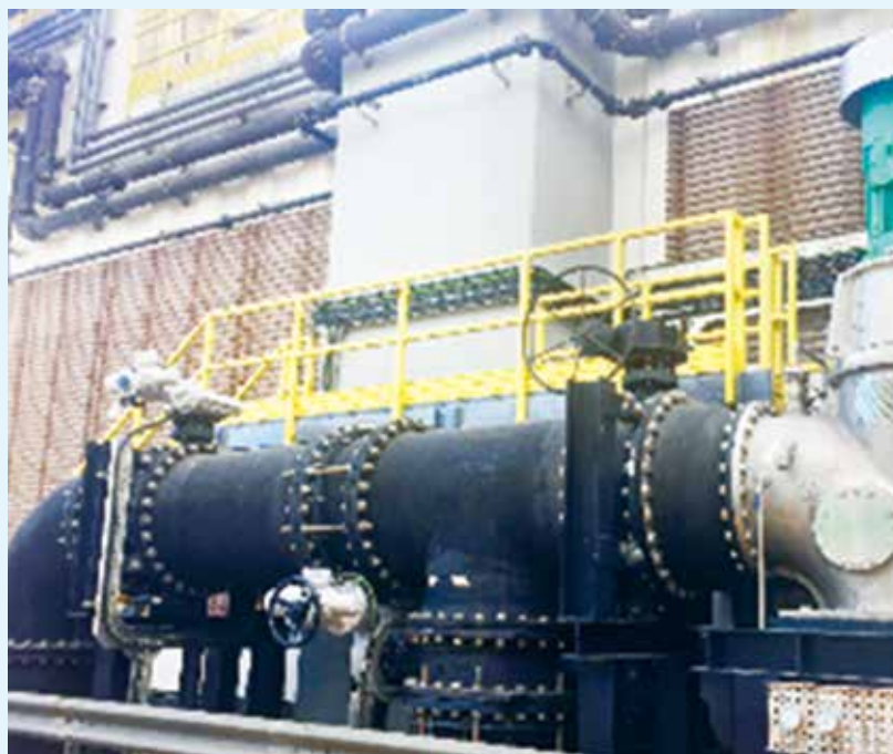
Hydro-turbine system at SCISTW 昂船洲污水處理廠的水力渦輪發電系統
