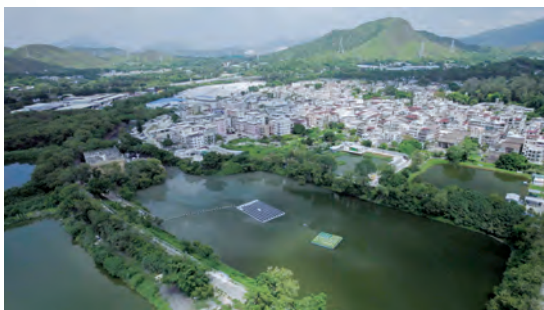
▲ 為減低水浸對村落的影响，渠務署實施鄉村防洪計劃，興建堤堰、建造雨水泵房及蓄洪池，以便在暴雨期間將雨水暫存及抽走，圖為1999年完成的新田鄉村防洪計劃(圖片攝於2022年)
