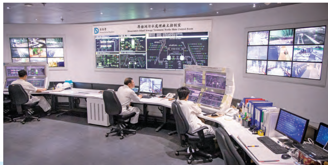
▲ 淨化海港計劃第二期甲主泵房控制室 HATS Stage 2A Main Pumping Station Control Centre
