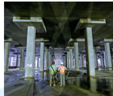
▲ 大坑東蓄洪計劃是香港首個大型地下蓄洪計劃，於2004年9月落成啟用，於暴雨期間大幅減少流入旺角下游的地面徑流，以減輕下游雨水排放系統的負擔，從而解決該區的水浸問題
