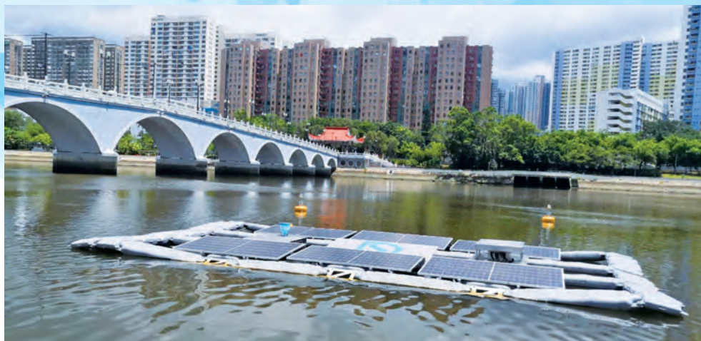
◀ 設於沙田城門河的浮式太陽能模擬系統 (2022年8月落成)
