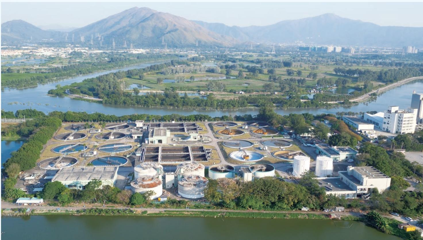
渠務署計劃將元朗污水處理廠淨水能力提升至更高的三級水平
