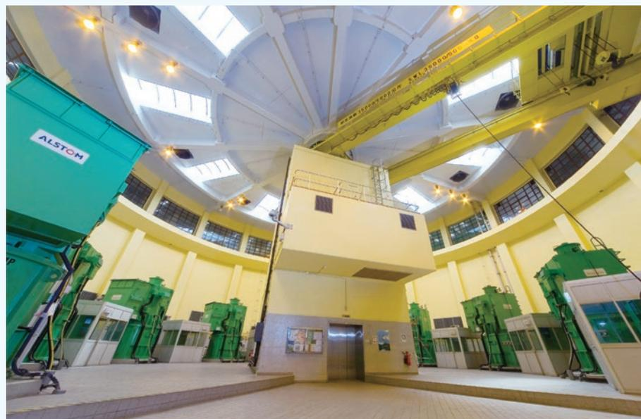
昂船洲污水處理廠「淨化海港計劃」一期主泵房內的8台高壓污水泵發動機
