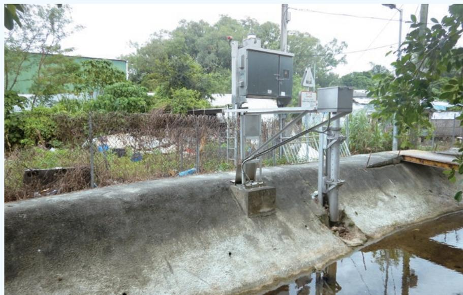
渠務署利用地區性洪水警告響號系統，通知尚未完成防洪工程和容易受水浸影響的地區。
