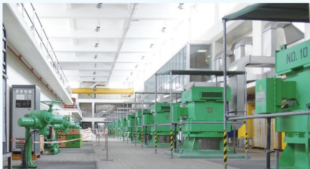
長沙灣污水泵房的3.3kV高壓電離心式污水泵
