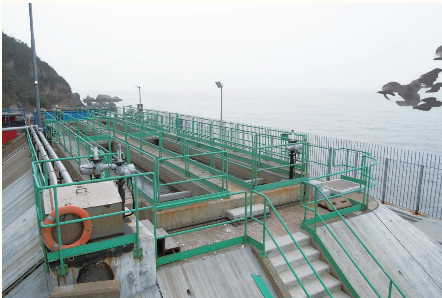
建於1983年的大澳雙層沉澱池是香港首間一級污水處理廠
