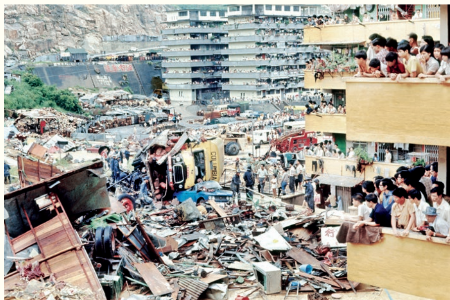
1972年「六一八」雨災後，東九龍翠屏道被傾瀉山泥覆蓋。
