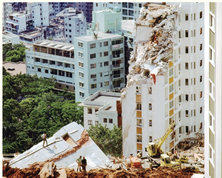
1972年「六一八」雨災兩幢位於旭龢道的大廈在山泥傾瀉中坍塌。是次滑波的泥石流量多達40 000立方米。
