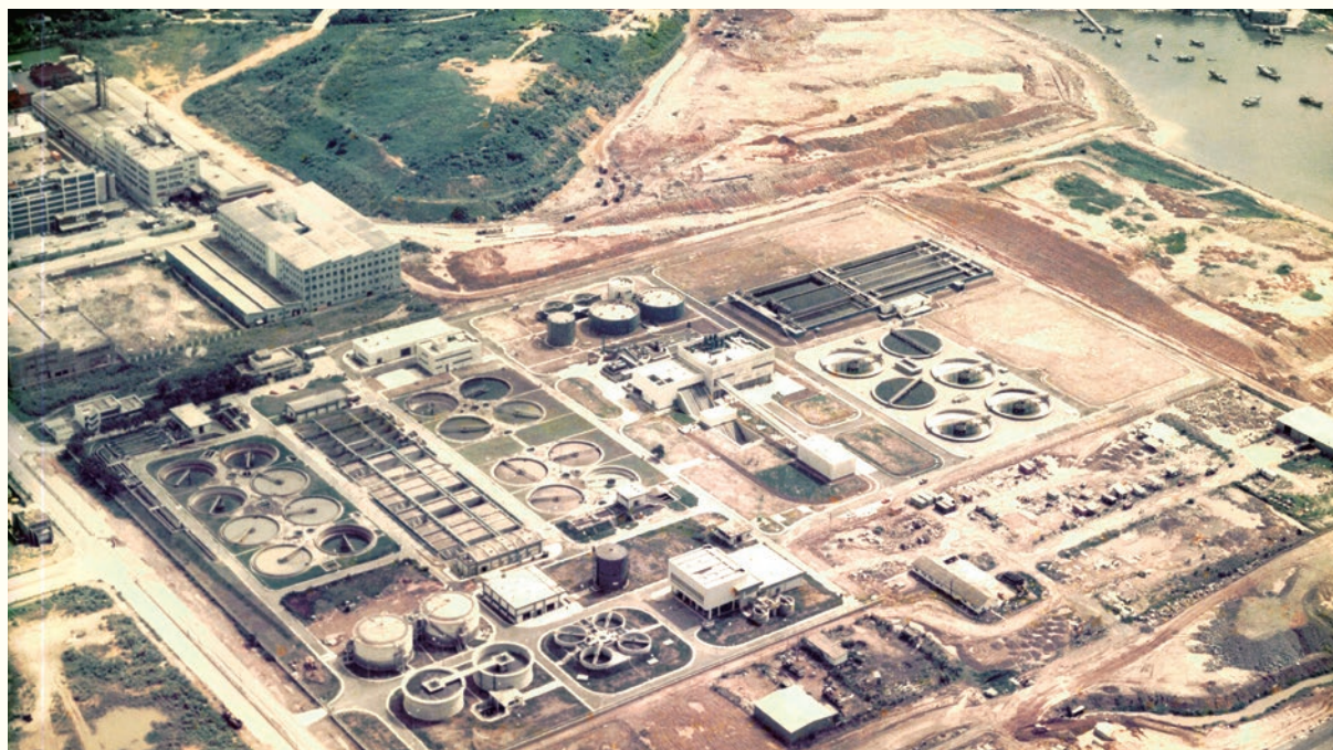
大埔污水處理廠位於大埔工業邨側，佔地12公頃。
