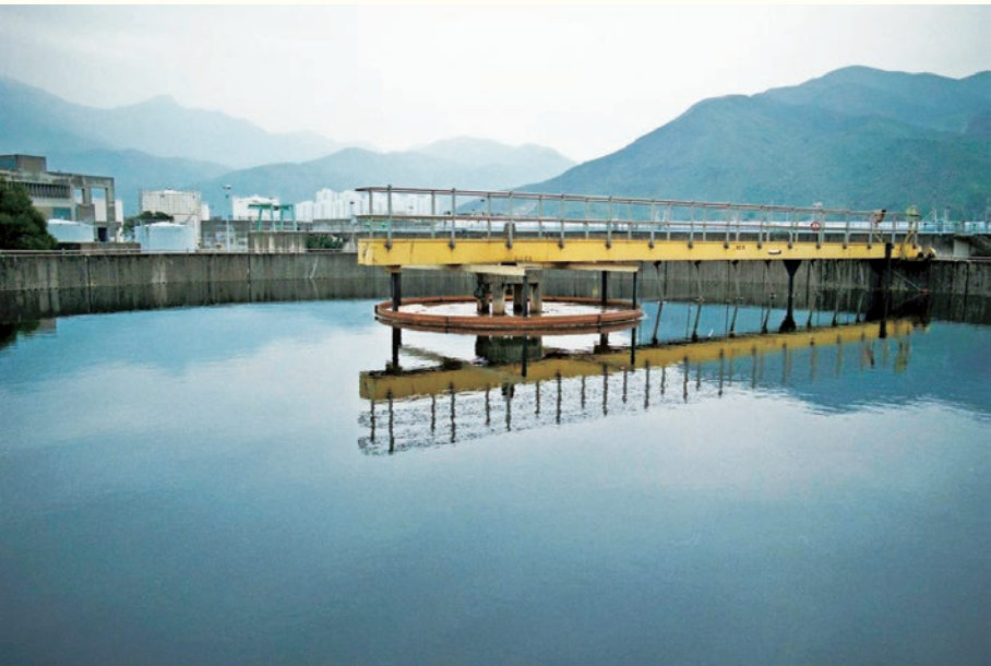
沙田污水處理廠的沉澱池
