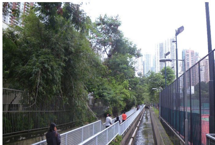
工程前的大坑明渠
