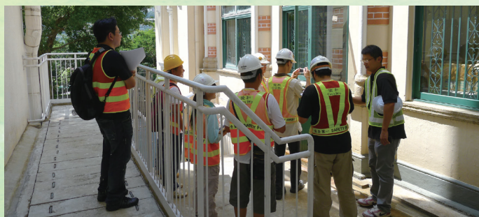
為二級歷史建築進行結構性測量
