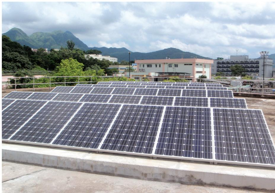
元朗污水處理廠天台裝設太陽能光伏系統，
