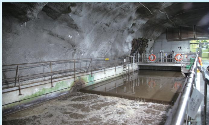
赤柱污水處理廠早在1995年2月落成啓用，為赤柱半島、大潭、春磡角和紅山半島地區超過27 000人提供污水處理服務。現時每日的處理量達8 800立方米，是岩洞污水處理廠的成功先例
