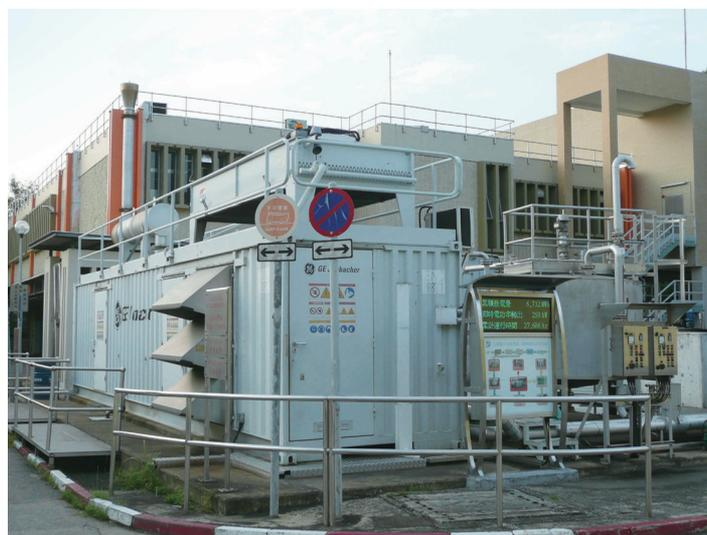
石湖墟污水處理廠的電熱聯供發電機
