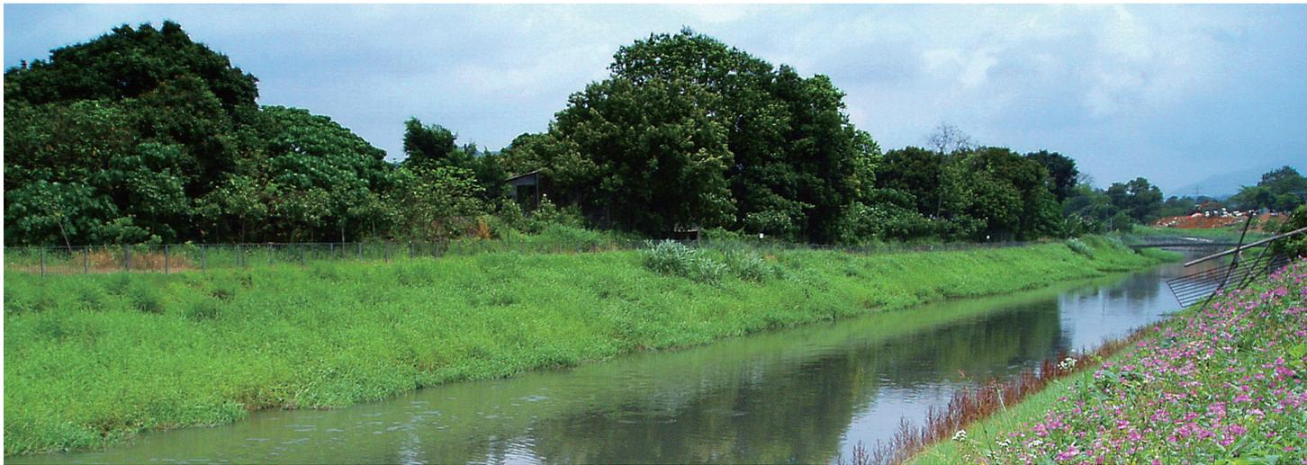
雙魚河上游採用土工布鋪設河堤及河床
