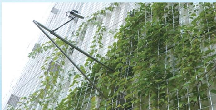
外牆裝有溫度探測的紅外線感應器
