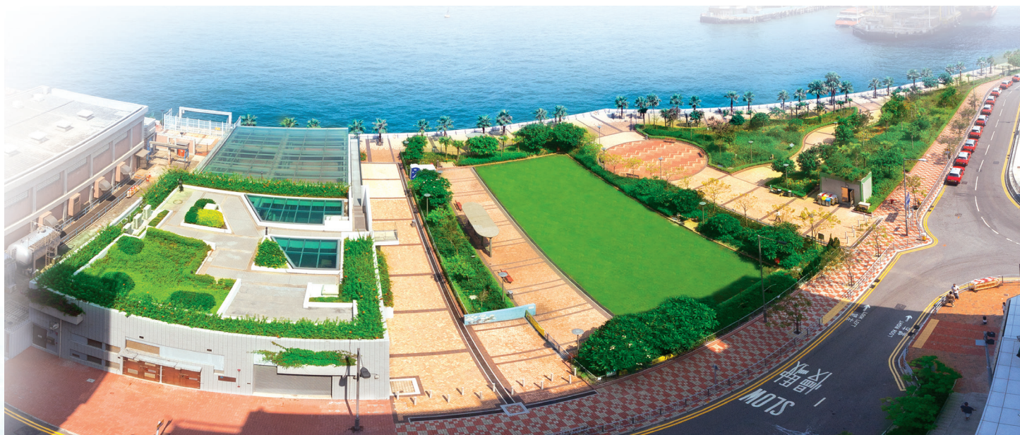
上環雨水泵房
