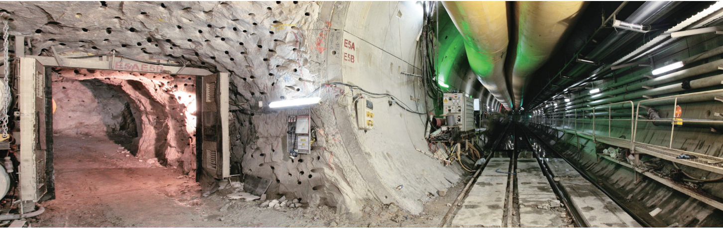
主隧道鑽挖及連接隧道爆破同步施工
