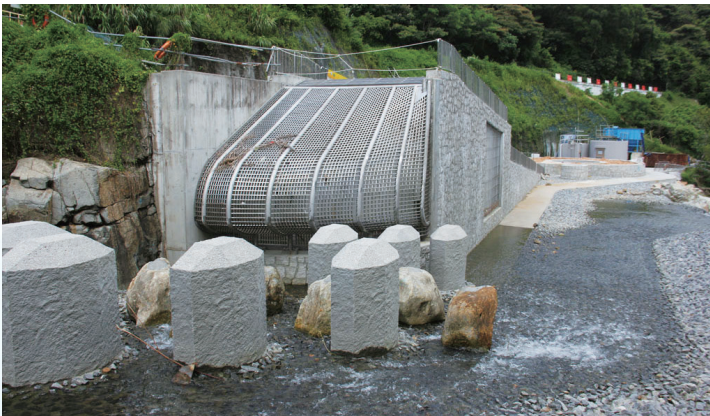
曹公潭進水口
