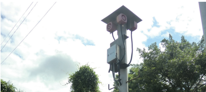
新界洪水橋丹桂村的洪水警告響號系統
