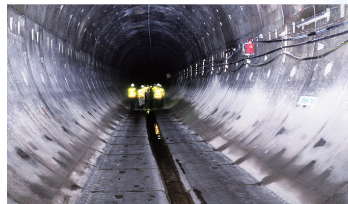
港島西雨水排放隧道內
