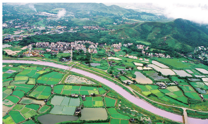
河道改善工程完成後的河上鄉
