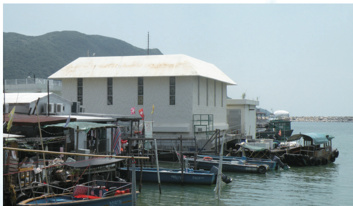
大澳永安街雨水泵房
