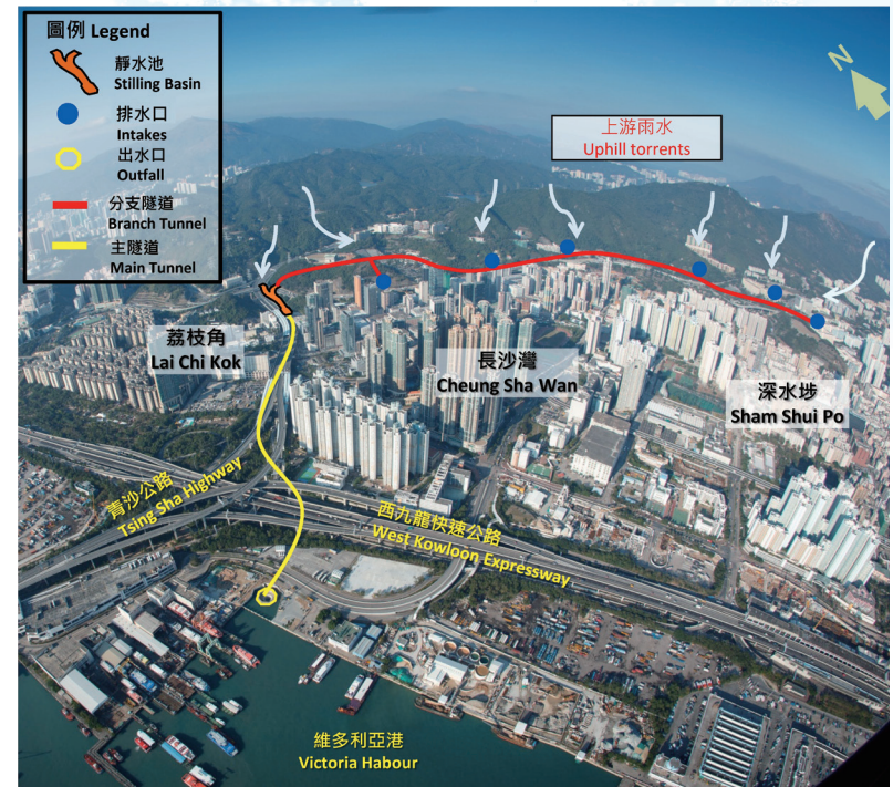
荔枝角雨水排放隧道的位置
