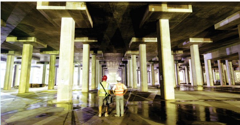
大坑東地下蓄洪池內
