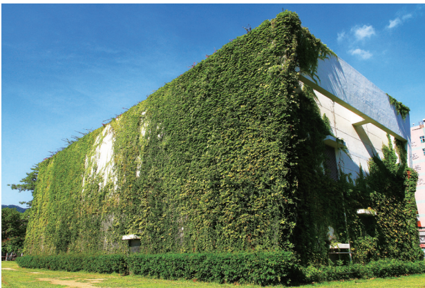
大坑東地下蓄洪池雨水泵房外貌
