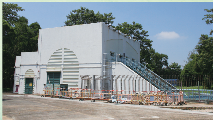
上水鄉雨水泵房
