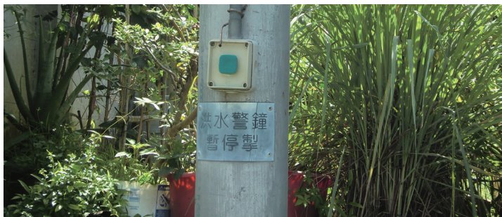
新界洪水橋丹桂村的洪水警告響號系統
