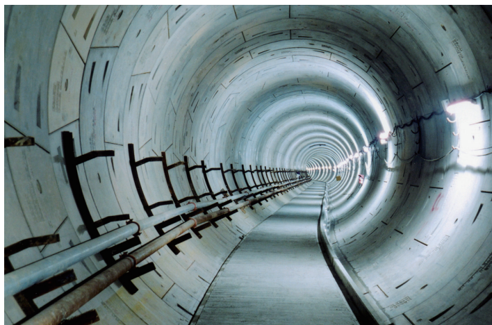
啟德雨水轉運隧道內
