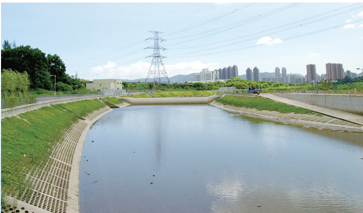
旱流抽水站及充氣堤壩
