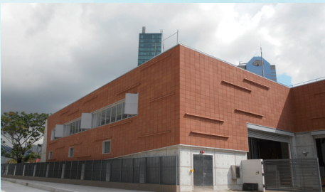
已建成的九龍灣污水截流站
