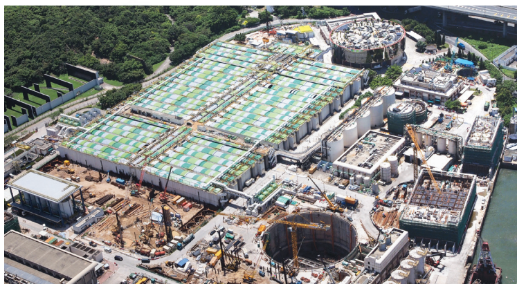
昂船洲污水處理廠的擴建工程 (圖為建設中的新主泵房)
