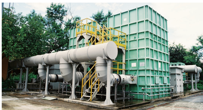
沙田污水處理廠的生物滴濾除味系統，有關設施(左圖)及示意圖(右圖)
