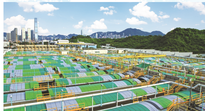
昂船洲污水處理廠的沉澱池已完成覆蓋工程
