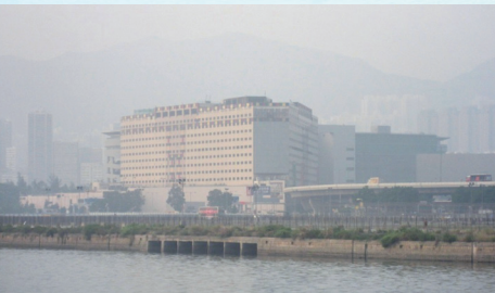
九龍灣箱形雨水渠出口
