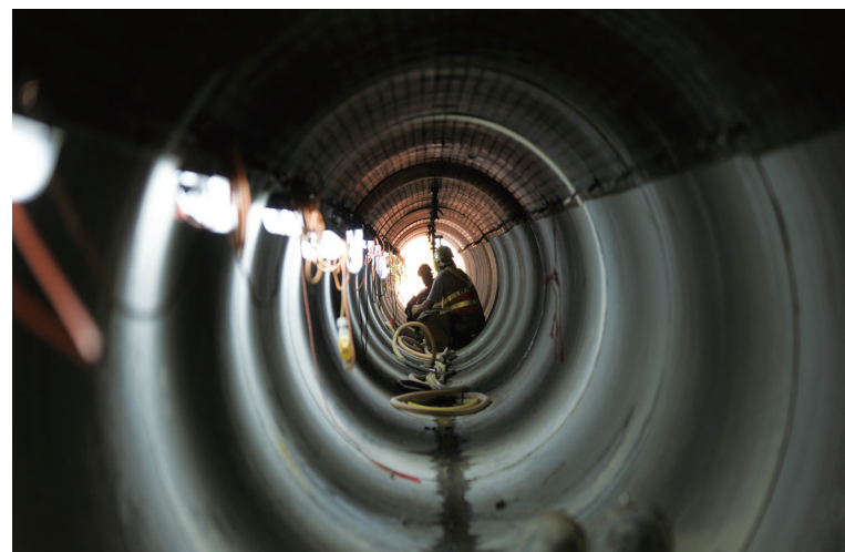
敷設主幹污水渠後進行內壁防護工序
