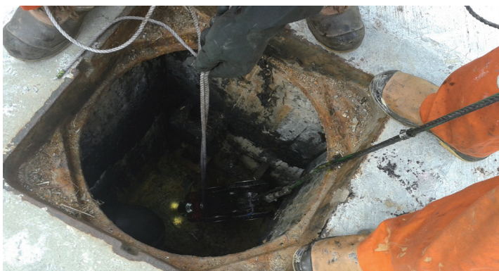
閉路電視勘測實況
