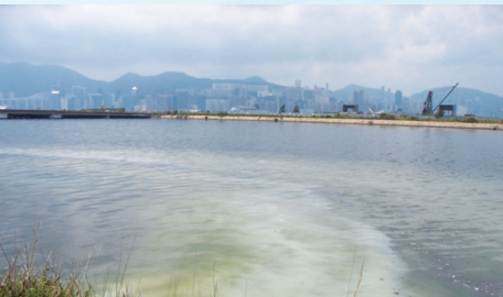
九龍灣箱形雨水渠在污水截流工程前曾出現旱流污水
