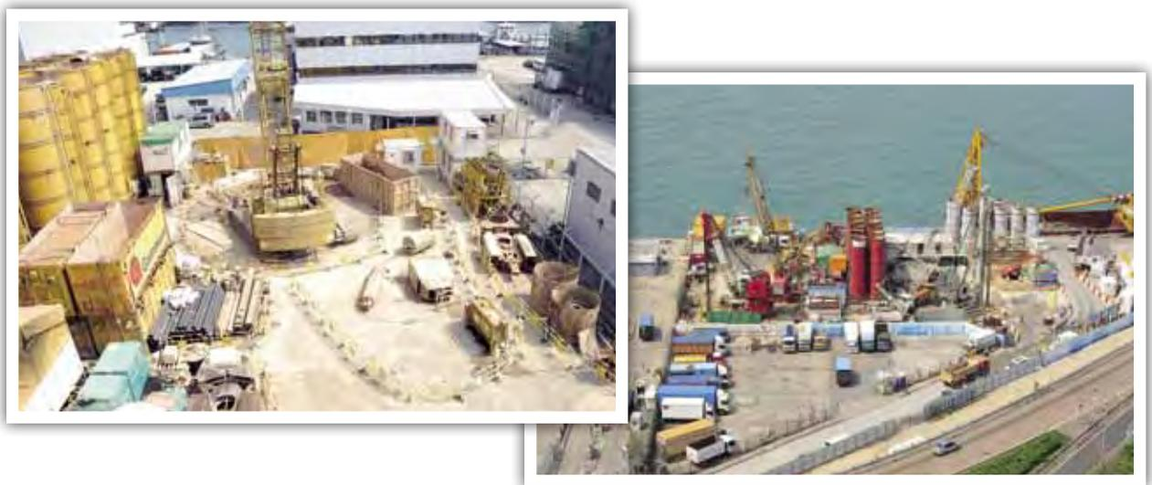
「淨化海港計劃」第二期甲在昂船洲（左圖）及西營盤（右圖）進行深層污水隧道的豎井鑽挖工程
