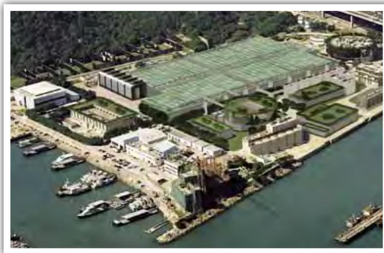
「淨化海港計劃」第二期甲工程——覆蓋後的昂船洲污水處理廠沉澱池（電腦模擬照片）
