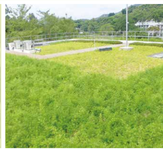
石涌凹污水泵房 Shek Chung Au Sewage Pumping Station
