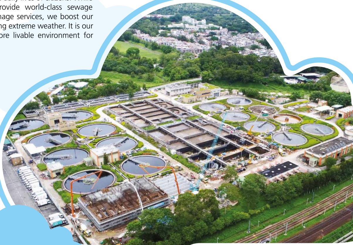
石湖墟污水處理廠改善工程 Shek Wu Hui Sewage Treatment Works Improvement Project
