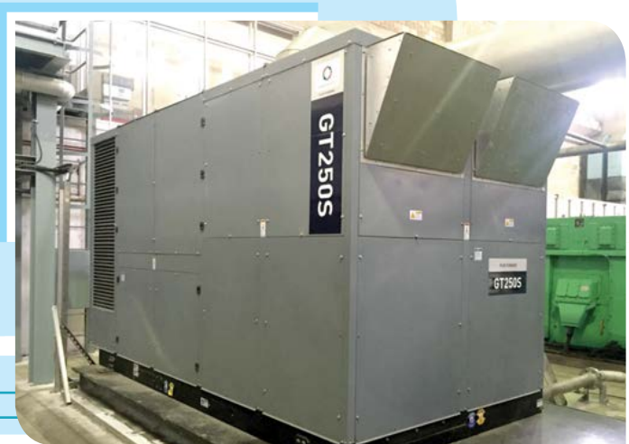
沙田污水處理廠的渦輪發動機 Gas turbine at Shatin STW
