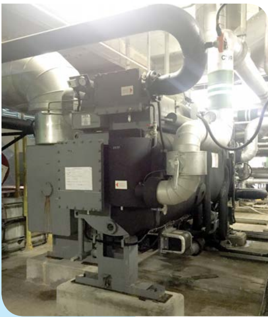
沙田污水處理廠的吸收式製冷機 Absorption chiller at Shatin STW
