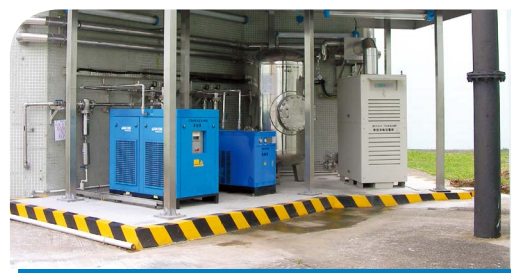
元朗污水處理廠的微型渦輪發動機 Micro-turbine engine at Yuen Long STW
