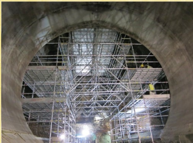
排放水隧道內壁的襯層工程 Internal lining works of effluent tunnel
