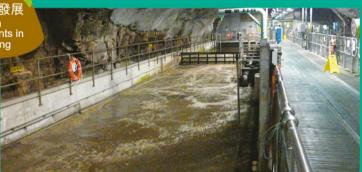
香港首座設於岩洞內的赤柱污水處理廠於1995年起投入服務。這座二級污水處理廠設計污水處理量為每日11,600立方米,現時每天接收來自赤柱區27,000人約每天9,000立方米污水。廠房設於三組大約120米長、15米寬和17米高的岩洞,並由超過450米行車和通風隧道及豎井連接起來。
