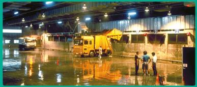
港島西廢物轉運站於1997年啓用,是一所在岩洞內建造的廢物轉運設施。它位處於堅尼地城海傍,為中西區及南區(部分)提供服務。由於該區並未有合適的垃圾轉運站選址,發展岩洞提供了一個合適及可行的解決方案。該岩洞長65米,寬度達27米,高12米。
