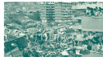
p.18 1972年「六一八」雨災後，東九龍翠屏道被傾瀉山泥覆蓋。」 香港特區政府渠務署，《澆洪淨流 混混而立》，2019年版，相片由香港特區政府新聞處提供
