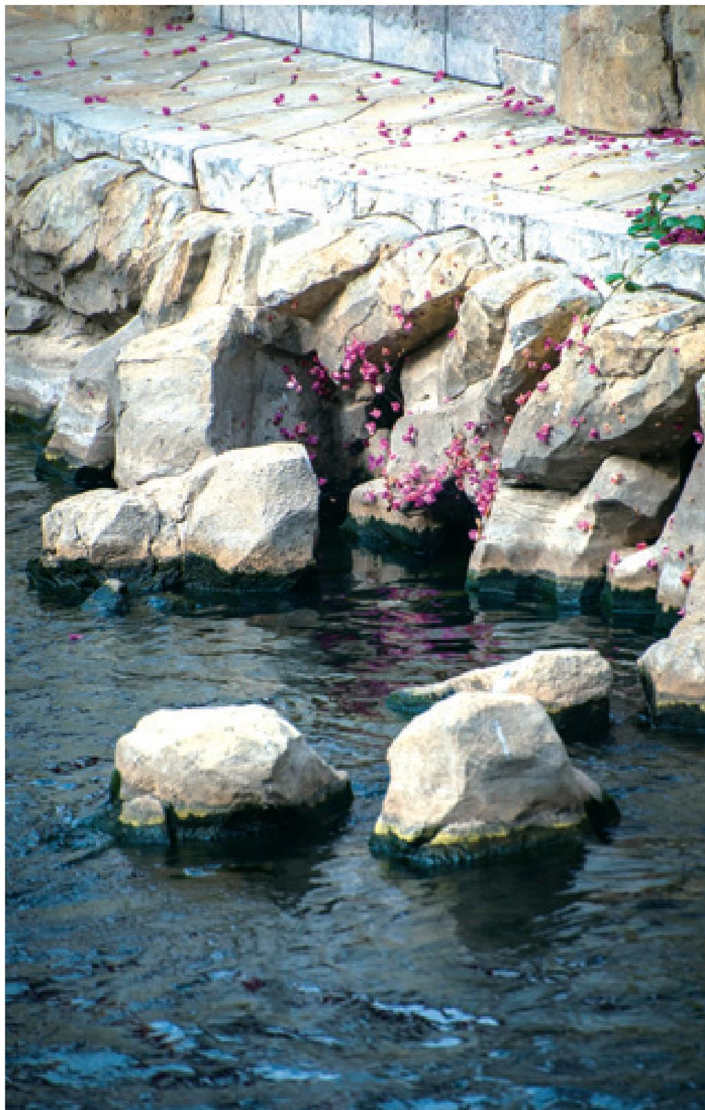
於河道加設魚洞穴及導流石，以改變水流方向及減低流水速度，給魚群休息。
