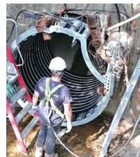
利用螺旋捲網式襯層方法進行修復工程
