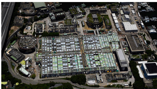
昂船洲污水處理廠
