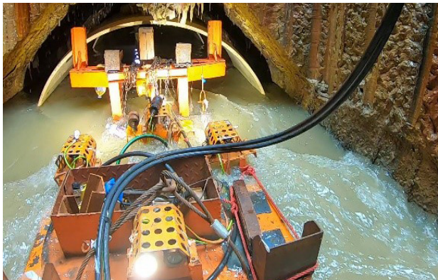
應用遙控機械人於運作中的污水幹渠內鋪設喉管
