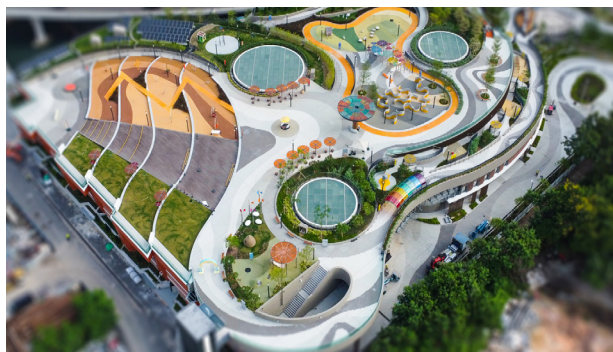
觀塘污水泵房上蓋的園景平台
