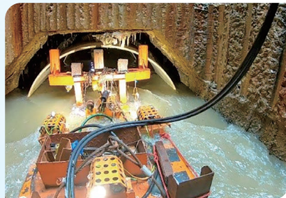
應用遙控機械人於運作中的污水幹渠內鋪設喉管
