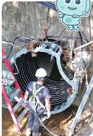
利用螺旋捲繞式襯層方法進行修復工程
