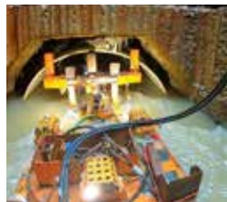
應用遙控機械人於運作中的污水幹渠內鋪設喉管
