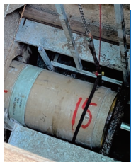
半自動推筒模式 修復渠管
