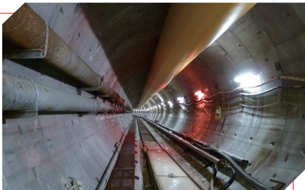
荔枝角雨水排放隧道
