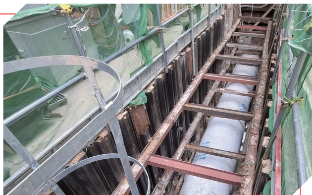
於柴灣怡豐街的雨水排放系統改善工程
