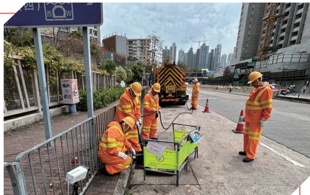
清理堵塞的排水設施
