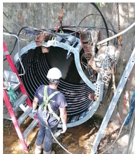
利用螺旋捲繞式襯層方法進行修復工程
