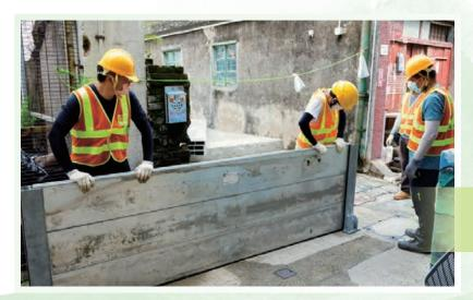
在大澳安裝可拆卸式擋水板 Installation of demountable flood barriers at Tai O
