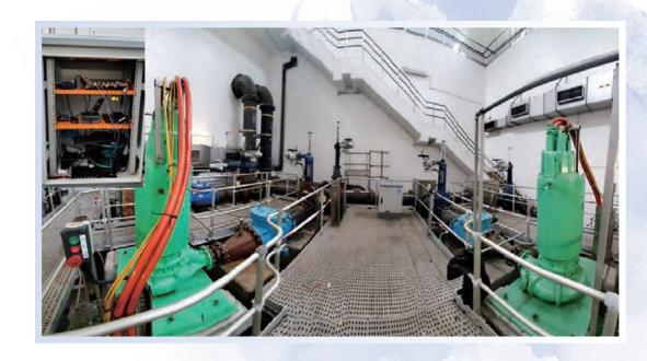
由Mohamed S. Ghidaoui講座教授領導的科大研究團隊透過分析實時監測數據以評估在深水灣和竹篙灣泵喉的健康狀況。該研究亦應用了主動瞬態檢測方法,診斷於竹篙灣、舂坎角道和舂坎角海灘的泵喉,並發現洩漏、氣穴、閥井淹沒及水泵過度振動等問題。該研究總結出連續瞬態測量為有效的泵喉診斷技術。
