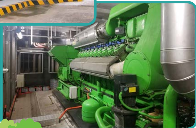
沙田污水處理廠的1.4兆瓦 熱電聯供發電機
