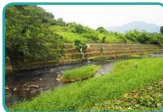
林村河上游堤岸的石籠河岸，有助植物生長及 營造自然生態環境
