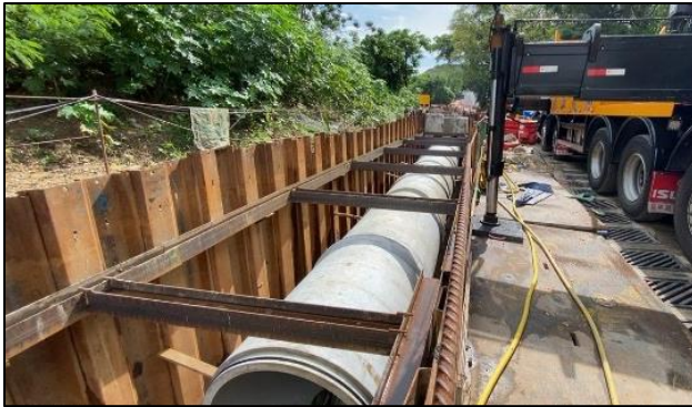
疏浚 - 加大渠管
