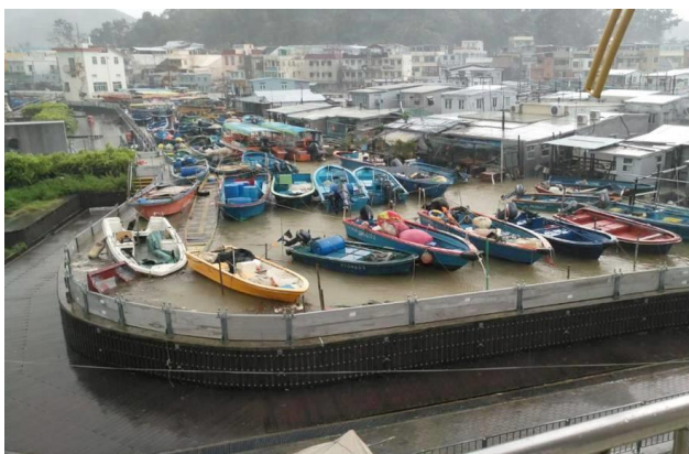
可拆式挡水板
