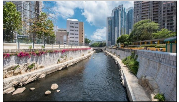
疏浚 - 河道治理
