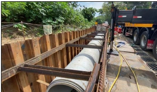
疏浚 - 加大渠管
