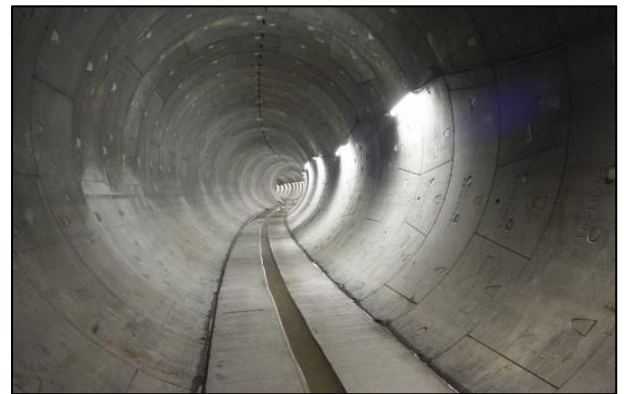
雨水排放隧道
