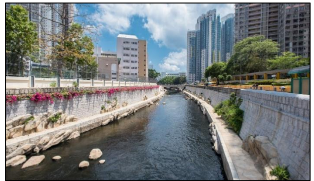
疏浚 - 河道治理
