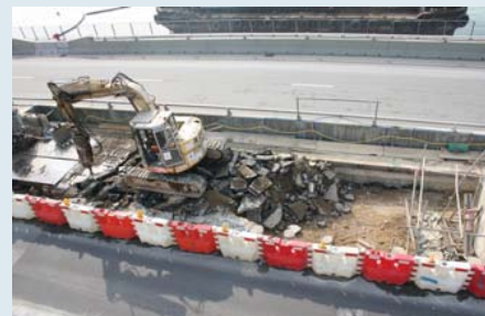
青山公路地下建造箱形涵洞
