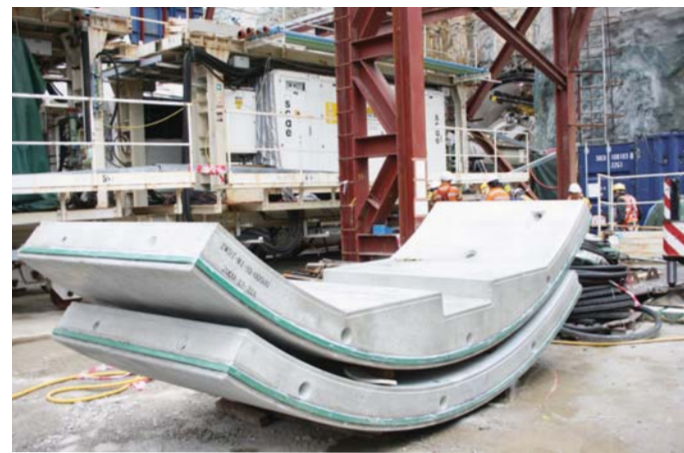
Precast concrete lining segments 預製混凝土組件
