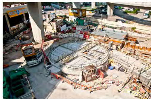
北角傾卸豎井工地 North Point Drop Shaft Site
