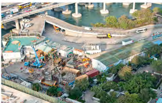
北角施工豎井工地 North Point Production Shaft Site
