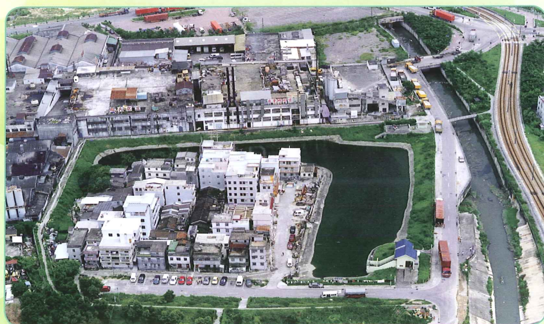
位於橋頭圍的鄉村防洪抽水計劃 Village Flood Pumping Scheme at Kiu Tau Wai
