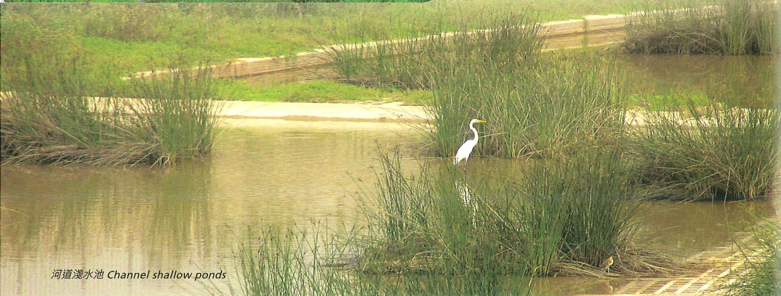
綠化河道 Green channel
