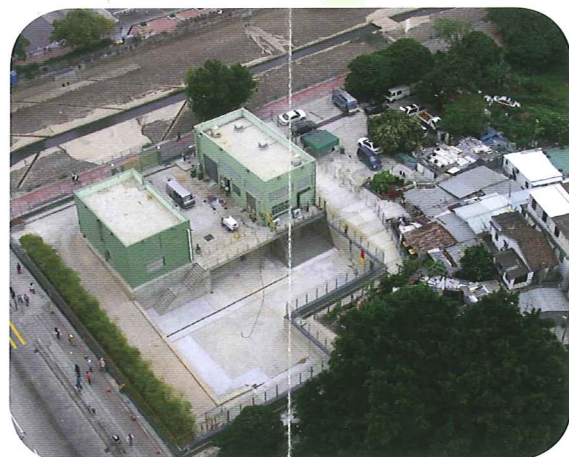
水邊村防洪抽水站 Shui Pin Tsuen Floodwater Pumping Station
