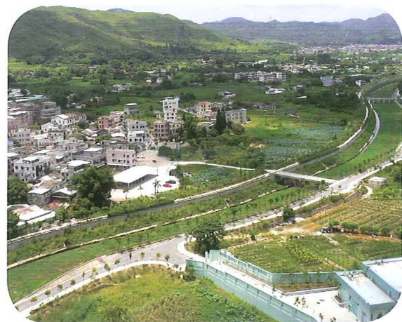
元朗排水繞道 Yuen Long Bypass Floodway
