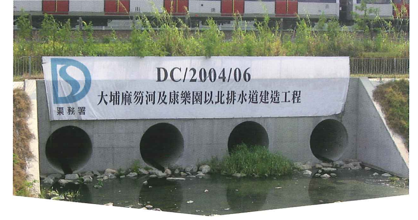
九龍坑東鐵路軌下的四條大型地下排水管道 The four large diameter stormwater conduits underneath East Rail embankment at Kau Lung Hang
