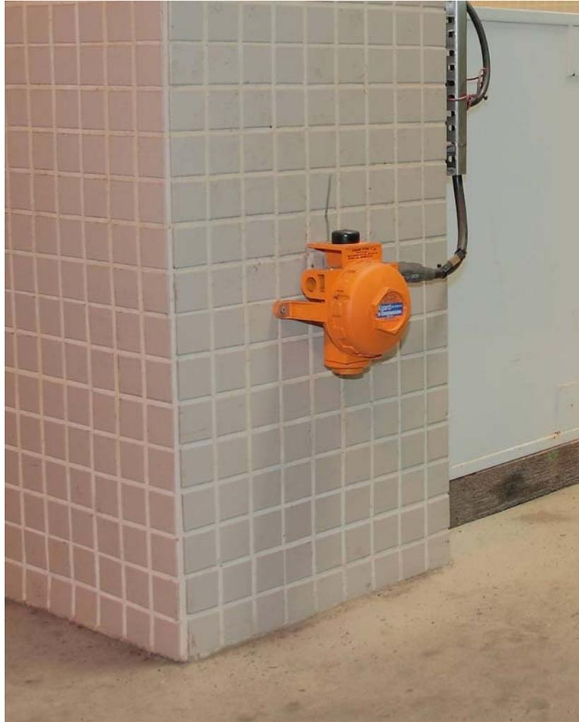
圖片3:固定式硫化氫探測器 (7台)
