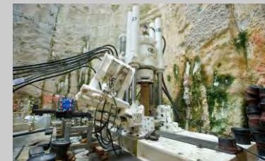
反井鑽挖機 Raise Boring Machine
