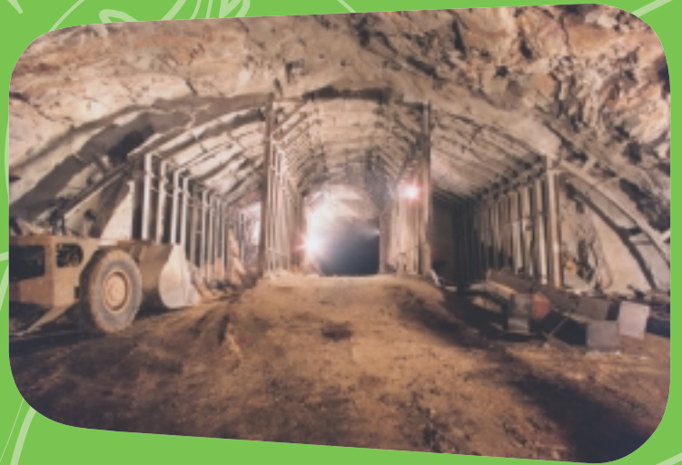
挖掘中的山洞 Cavern excavation
