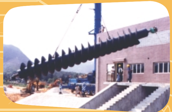
進行安裝螺絲泵工程 Installation of screw pump
