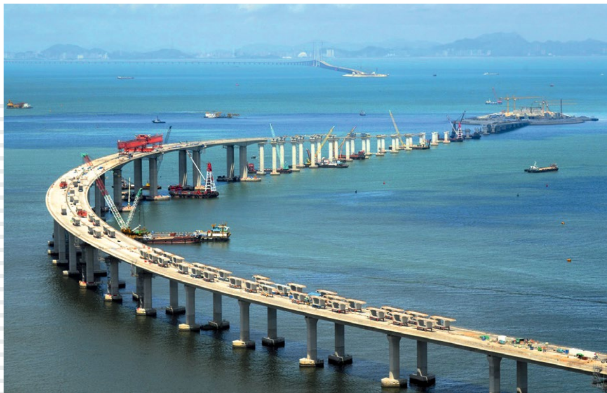
正在建造的港珠澳大桥香港接线。
