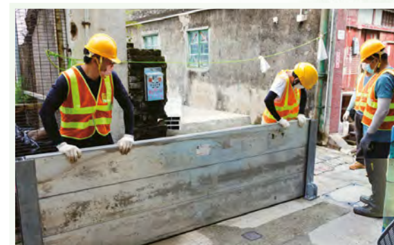
在大澳安裝可拆卸式擋水板 Installation of demountable flood barriers at Tai O
