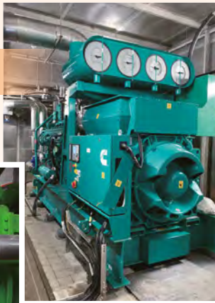
沙田污水處理廠的電熱聯供發電機 CHP generator at Sha Tin STW
