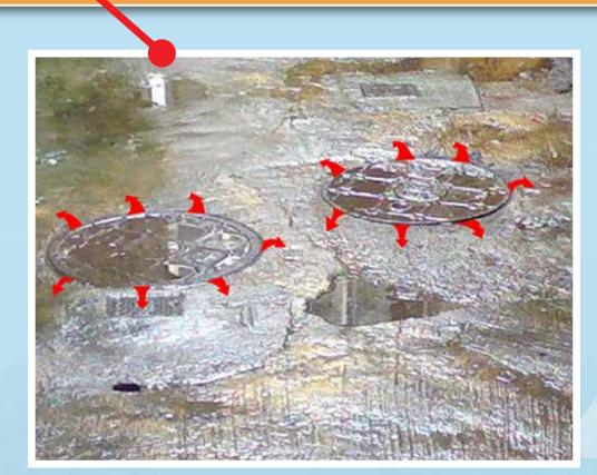
缺乏定時清缸,影響化糞池減除 污染物成效,更可能引致污水溢 出
