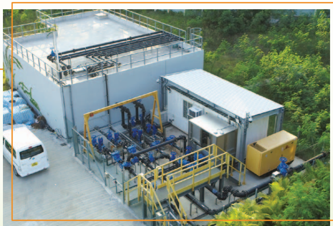
檢疫中心的污水儲存缸（左上角）和污水泵採用可持續擴建設計
