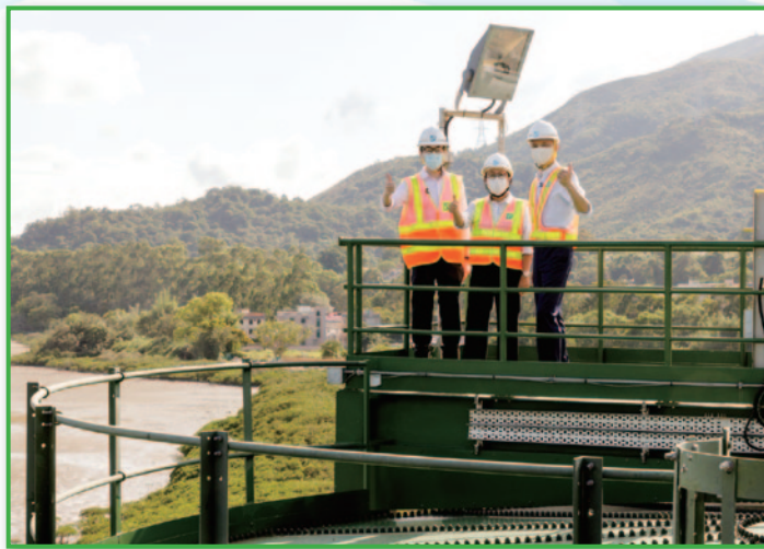
環境局局長黃錦星先生（右）、署長彭雅妮女士（中）及本署助理工程師何澤銘先生（左）到沙頭角污水處理廠第一期擴建工程的地盤視察
