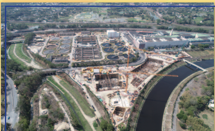
石湖墟淨水設施 - 主體工程第一階段
