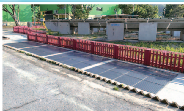
鋪設於太陽能發電場A區旁行人路上的可踏式太陽能光伏板
