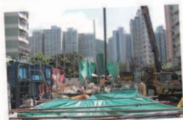
在鑽挖機周邊安裝雙重保護防塵帷幕
