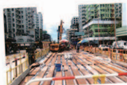
防污泥滲漏的打樁工作台
