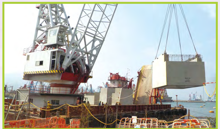
DfMA 組件從船上吊運到現場
