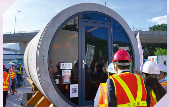
廢棄的巨型混凝土預製管改造成有空調的工人休息室
