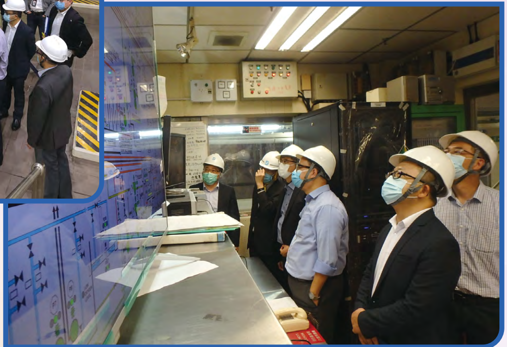
本署同事在控制室講解廠房系統操作
