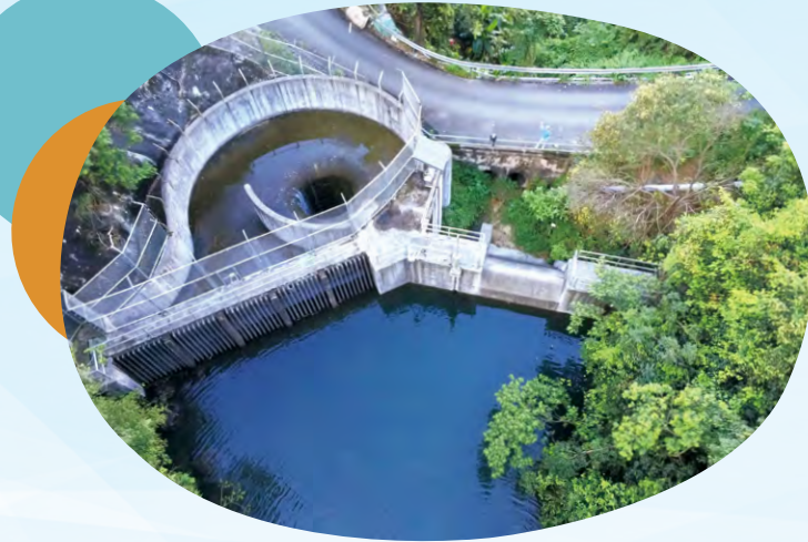
用航拍技術俯瞰引水隧道入口
