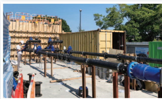
渠務署僅用七天時間興建一個污水泵房及 1.8 公里加壓污水管，將新田社區隔離設施的污水接駁至位於落馬洲管制站內的污水處理設施
