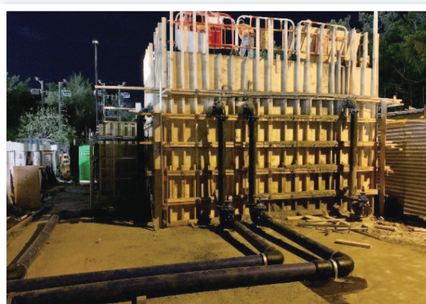
工程團隊 24 小時趕工興建泵房及敷設加壓污水管
