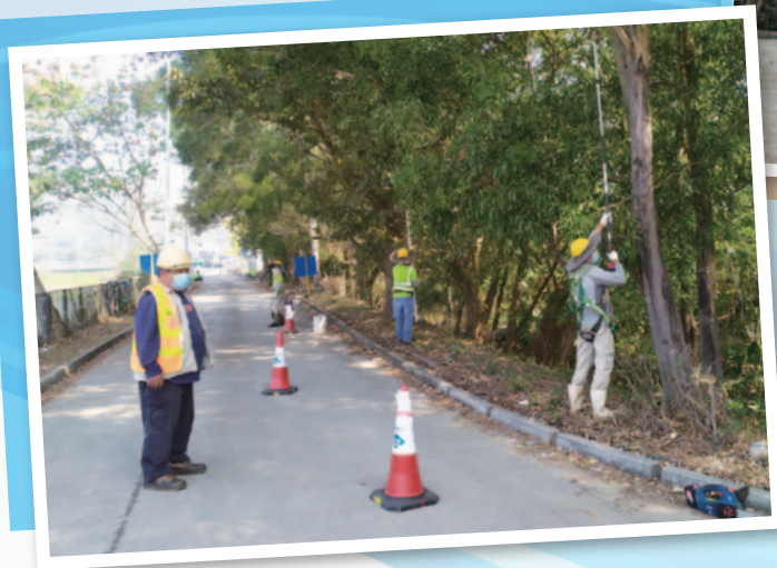
新界北渠務部於梧桐河的維修通道上進行緊急樹木修剪工作， 以配合車身較高的貨櫃車及重型貨車行走
