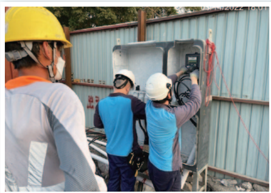
中電工程人員為污水泵房進行電力接駁及測試
