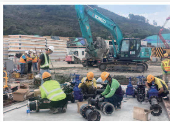
施工人員在乾井上進行喉管接駁工程
