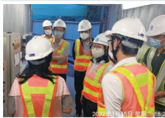
3月15日，署長（右三）到場見證洪水橋社區隔離設施污水泵房正式投入運作
