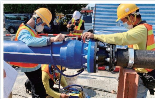
工程團隊為雙管加壓污水喉管進行最後接駁
