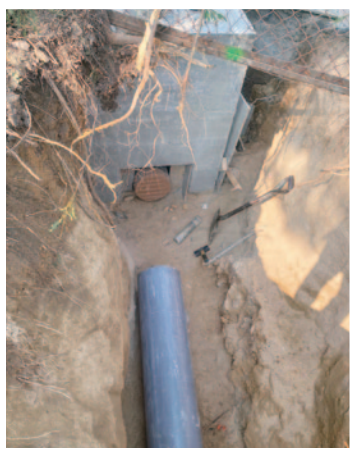
渠務署將新建的一條長約 30 米污水渠接駁至青衣 社區隔離設施的污水尾井 ( 圖片上方混凝土構建物 )
