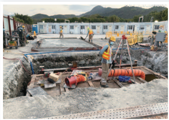
濕井預製組件已安裝在地底豎井，並進行地面乾井工程
