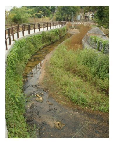
FIGURE 13 SINUOUS CONFIGURATION AT MA TSO LUNG RIVER
