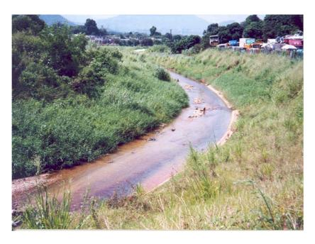
FIGURE 38 GEOTEXTILE REINFORCED GRASS EMBANKMENT AT NG TUNG RIVER
