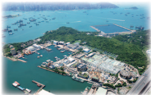
昂船洲污水處理廠
