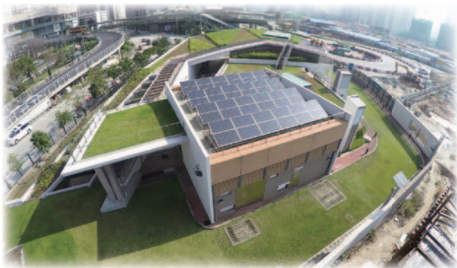
九龍城一號污水泵房
