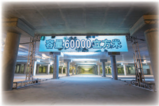
跑馬地地下蓄洪池
