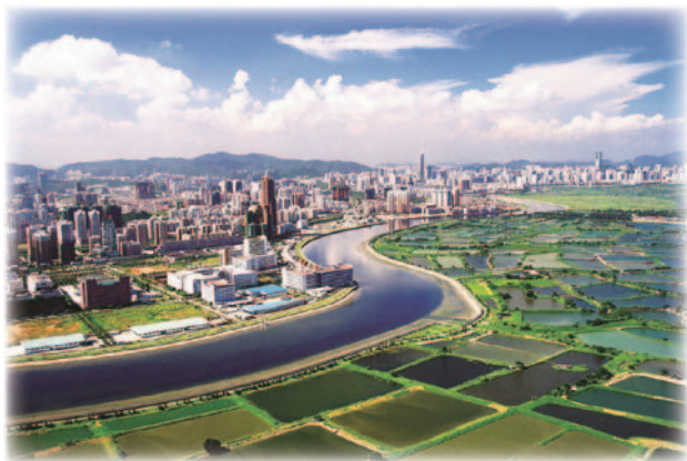
已完成第一、二及三期治理工程的深圳河
