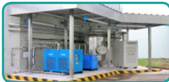
元朗污水處理廠的30千瓦微型渦輪發電機 A 30 kilowatt micro-turbine generator at Yuen Long Sewage Treatment Works
