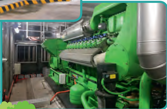
沙田污水處理廠的1.4兆瓦 電熱聯供發電機
