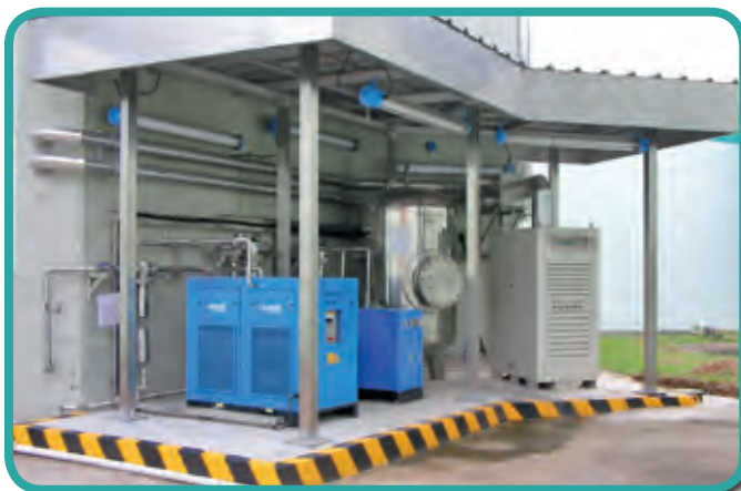
元朗污水處理廠的30千瓦微型渦輪發電機 A 30 kilowatt micro-turbine generator at Yuen Long Sewage Treatment Works
