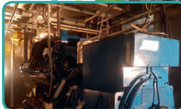
沙田污水處理廠新增的生物氣電熱聯供發電機
