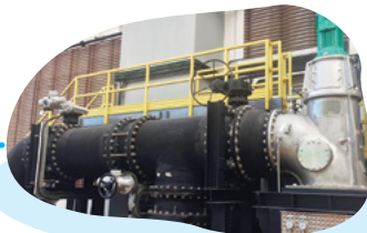
昂船洲污水處理廠的水力渦輪發電系統 Hydro-turbine system at SCISTW
